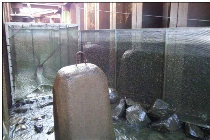
Bild 1: Fangeinrichtung mit Rechen und 10 mm Netzreue; Ansicht stromauf
