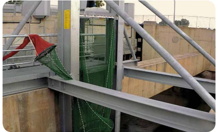
Bild 2: Stahlkonstruktion unterhalb der landseitigen Turbine mit Fanghamen
